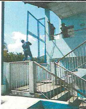
Foto 3: Ampliacion de altura de muro perimetral com marco de maya galvanizada
