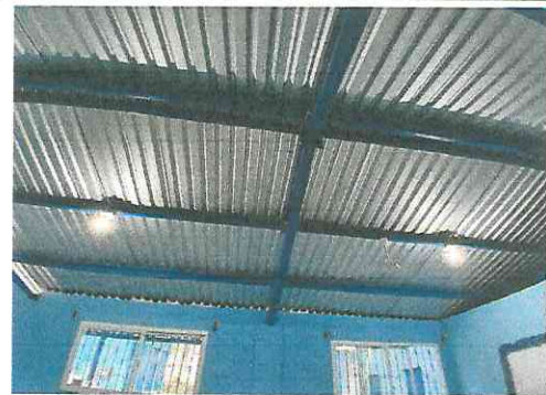
Foto 6: Mantenimiento a estructura (lijado, cambio de tubo , cepillado, sujeciones, aplicacion de pintura)
