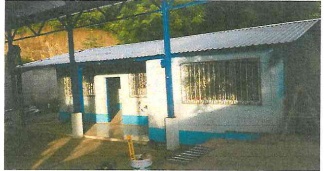
Foto 2: Instalacion de canal y bajada de pvc
