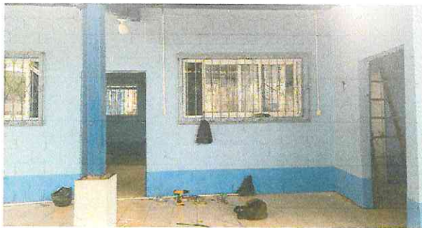
Foto 5: Instalacion de ventanas pvc mas vidrio
