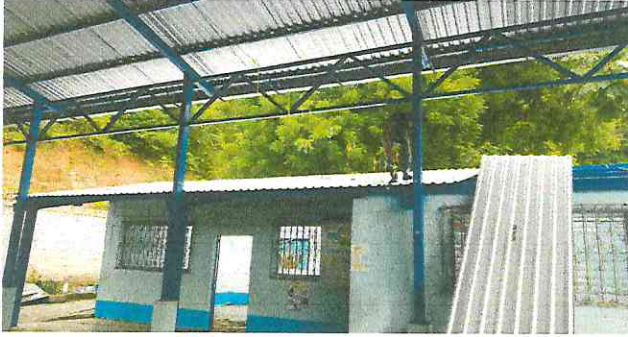
Foto1: sustitucion de lamina por lamina troquelada calibre 26
