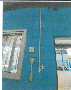
Foto 4: Sustitucion e intalacion electrica y ventilador de techo
